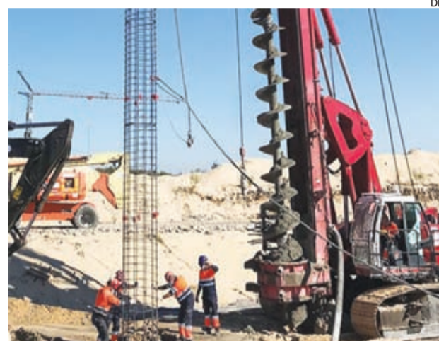
Fundações do novo Parque Eólico da Tocha já foram executadas
