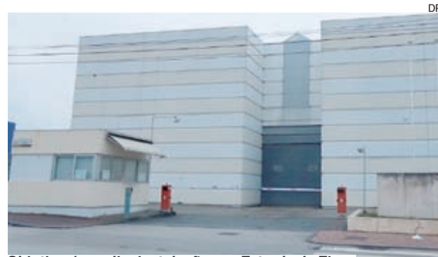
Objetivo é ampliar instalações na Estrada de Eiras
