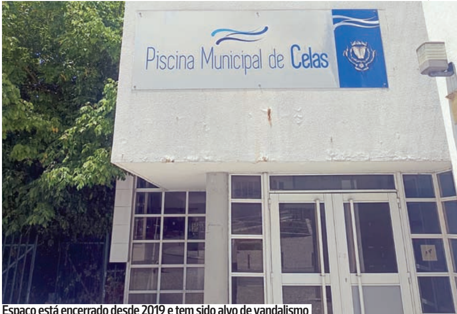
Espaço está encerrado desde 2019 e tem sido alvo de vandalismo
