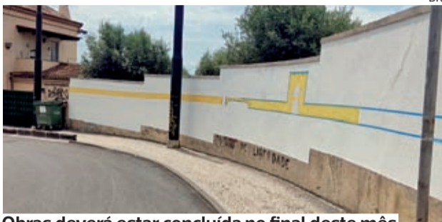
Obras deverá estar concluída no final deste mês
